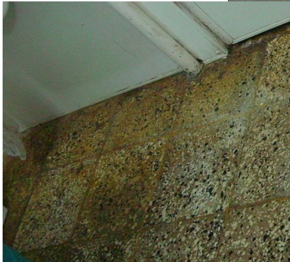
**Pisos de concreto y terrazo severamente careados en la superficie por ataque mecánico y/o químico que se puede reparar mediante recubrimiento de Macropisos y restaurar las características de higiene, belleza y durabilidad del inmueble**
