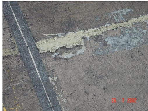
**Junta reparada con epóxicos utilizando 2 métodos diferentes: el sistema de cortar el dado rellenándolo posteriormente con mortero epóxico y reconstruyendo la junta, obsérvese que al agrietarse los bordes se termina con un sistema de 3 juntas, una a cada lado de la reparación mas la junta cortada al centro del dado. Adicionalmente observamos una junta reparada con epóxico rellenando sencillamente la junta sin abrirla**
