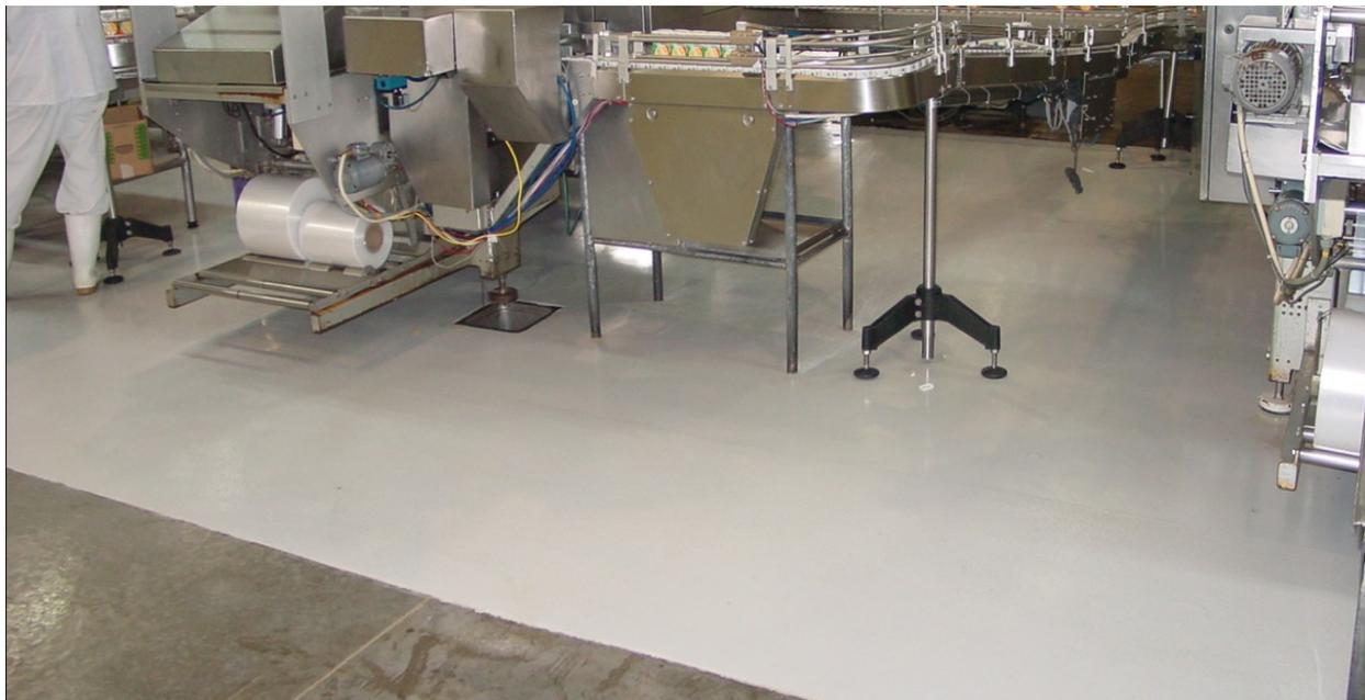
**Restauración del piso con recubrimiento de Macropisos sin juntas y con aditivo antimicrobiano Microban**
